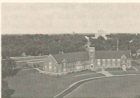
6 Le Séminaire Théologique Nazaréen. Fondé en 1945. La construction date de 1954.
